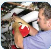
Nous ajustons les appareils des réseaux d'eau (pompes, tours d'eau, échangeurs, refroidisseurs, serpentins, valves...) afin que ceux-ci fonctionnent adéquatement et répondent aux exigences prescrites. Nous utilisons des débitmètres ultrasoniques portables ou des manomètres hydroniques pour mesurer les débits des fluides. Les instruments sophistiqués utilisés par nos techniciens sont étalonnés sur une base périodique. Le certificat d'étalonnage peut être fourni sur demande.
